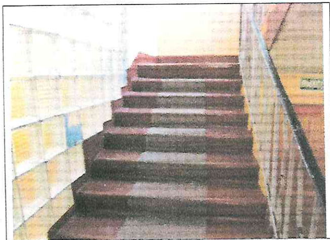
Фото №13 - Вид лестницы
