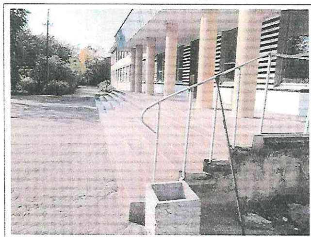
Фото №4 – Наружная лестница главного входа
