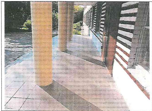
Фото №5 – Входная площадка главного входа
