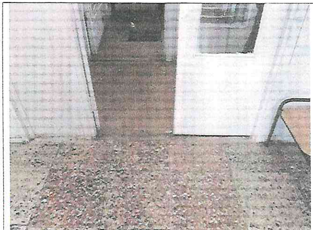
Фото №8 – Внутренняя входная дверь
